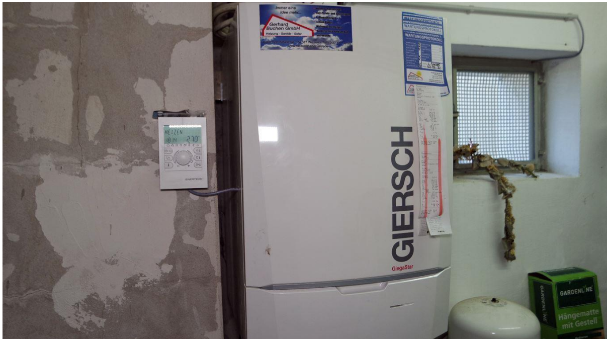
Brennwert-Erdgas-Zentralheizung, Baujahr 2010
