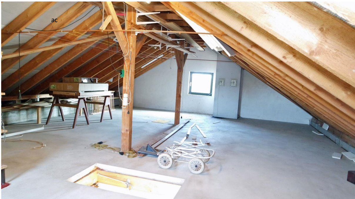
70 m 2 Ausbaureserve im Dachgeschoss (massive Decke zum DG)
